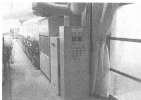
さいたま市にある農園に導入した「施設園芸用古井戸熱源活用システム」
